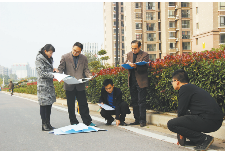
对市区道路建设进行现场审计
