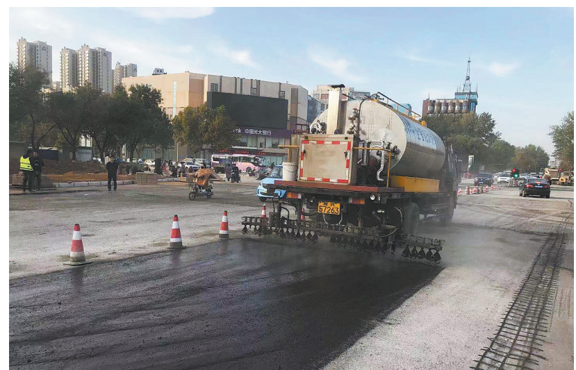
施工机械正在作业
