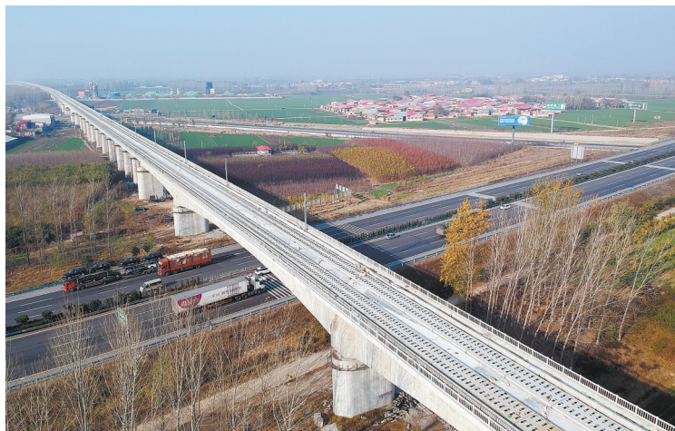
在郑渝高铁长葛段,郑渝高铁与京港澳高速公路线交织在一起,气势不凡。 本报记者 乔利峰 摄
