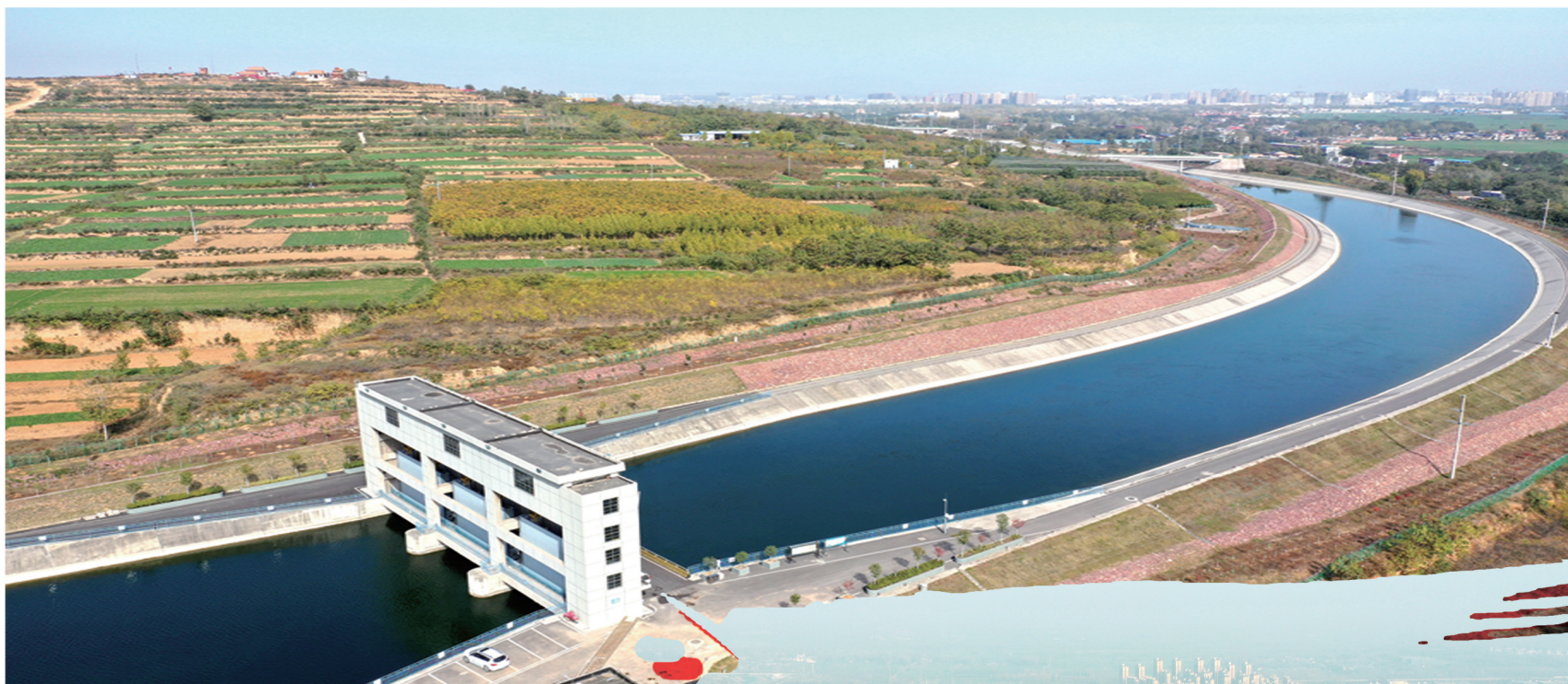
12月1日，航拍的位于禹州市的南水北调中线工程总干渠事故闸附近的景色。
