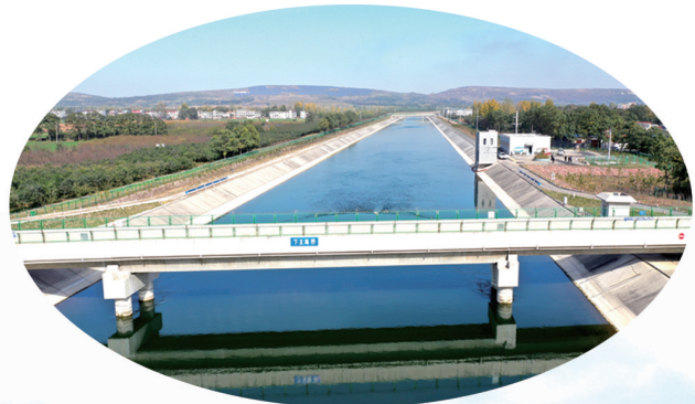
12月1日，航拍的位于禹州市的南水北调中线工程总干渠下王南公路桥附近的景色。
