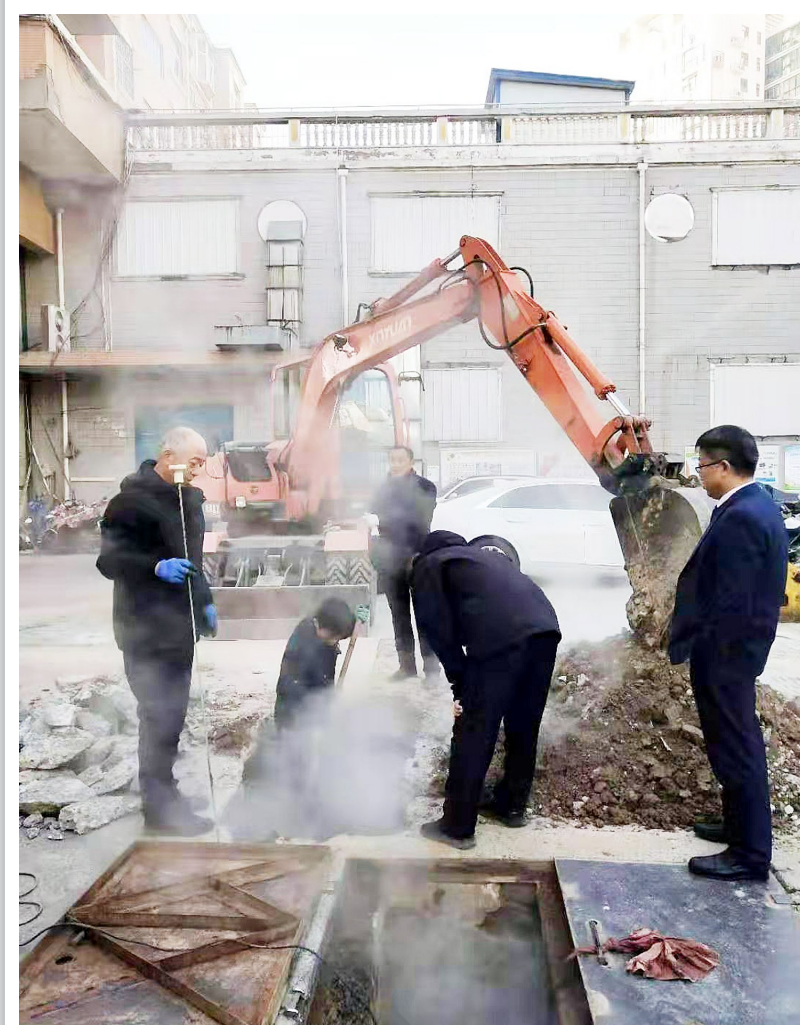
万和物业工作人员在“刨地”抢修供热管道
