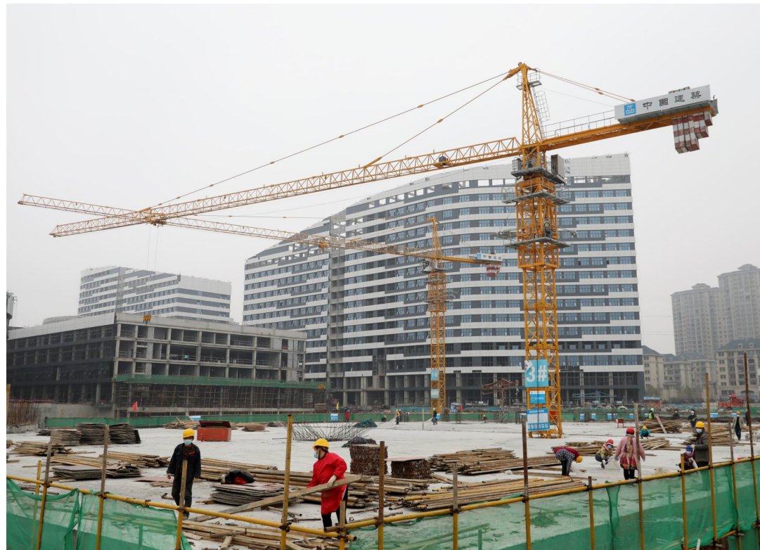
近日,在市中心医院新院区项目建设工地上,工人正在加紧施工。该项目总投资17.88亿元,总建筑面积304224.6平方米,规划床位1500张,将建设以现代化综合性三级甲等医院为标准的医疗卫生服务中心。
