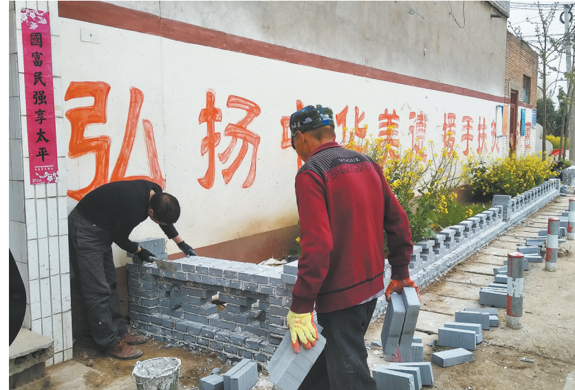
3月30日,建安区西街北岸村深入开展“三清一改”行动(清垃圾、清塘沟、清畜禽养殖等农业生产废弃物,改变影响农村人居环境的不良习惯),对主干道两侧花坛统一修砌围墙。市委宣传部驻村第一书记连良坚持脱贫攻坚与乡村振兴有机融合,带领群众在改善农村人居环境上下功夫,协调筹措资金硬化了该村全部道路,修通了排水沟,清理了河道,美化了乡村环境。武鹏亮 摄
