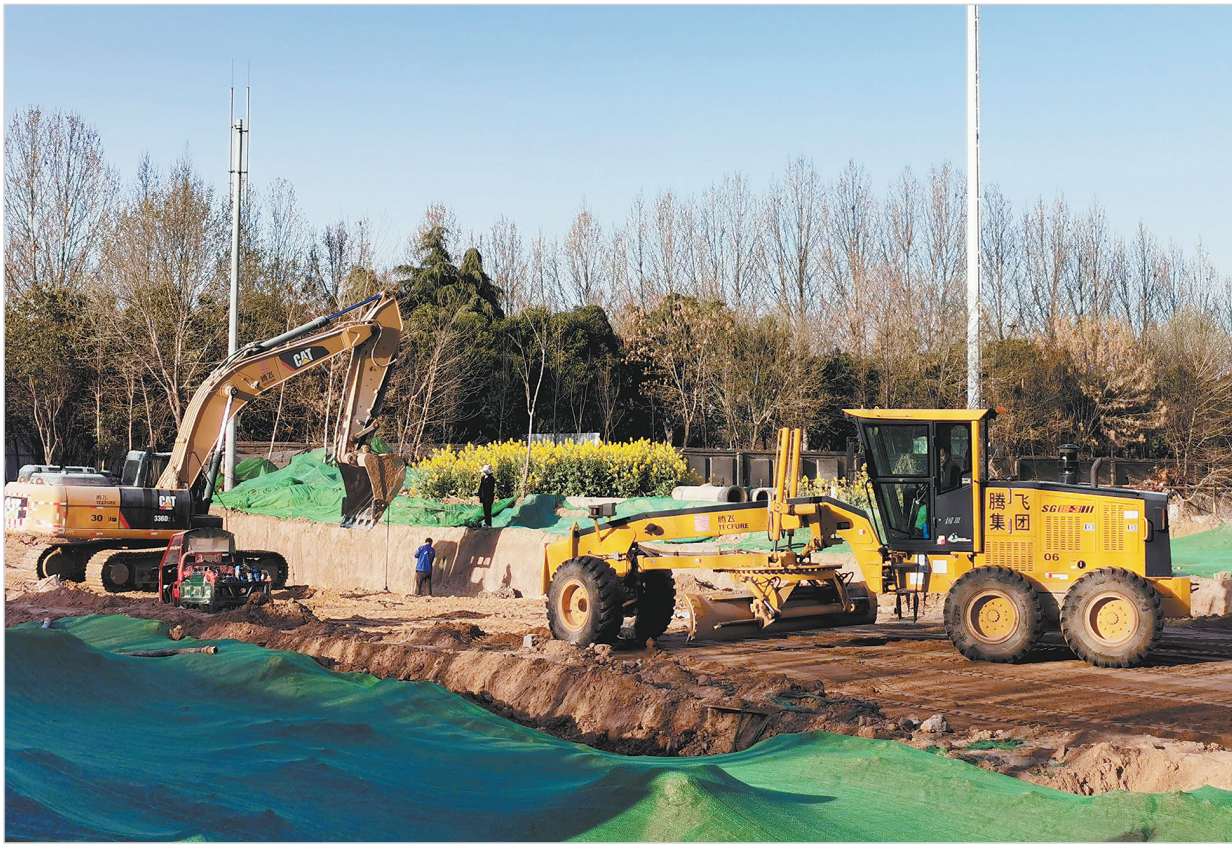
▲3月30日,在东城区景福路项目施工现场,机声隆隆,工人加紧道路施工建设。我市各地采取多种措施,强力推进重大项目复工复产,形成抢时间、赶进度的良好局面。
