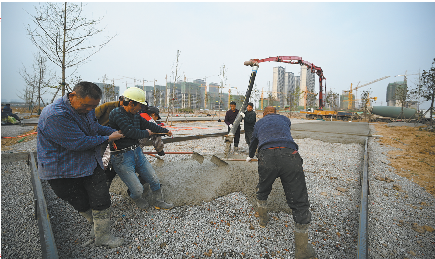
在瀾陵湖健身公园项目现场,建设者们正在紧张施工。该公园建成后,许昌市将新增一处环境优美的都市休闲空间。 侯聪 摄
