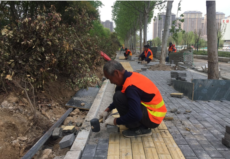
文峰北路永昌路口附近,工人认真铺设地砖
