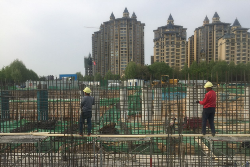
工人正在文峰北路过北海水系桥施工
