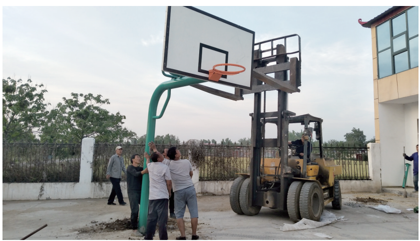
建安区北岸村是省级贫困村。近年来,驻村工作队千方百计协调项目和资金,对村内道路进行了硬化亮化,新建了文化广场,安装了健身器材,全村面貌焕然一新。图为5月14日,北岸村驻村干部和党员正在安装篮球架。武鹏亮摄
