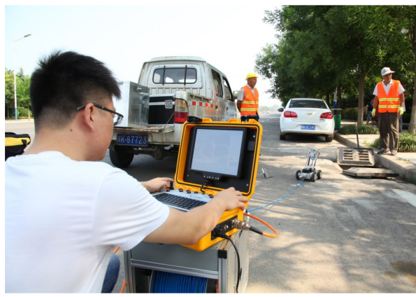
工作人员用管道机器人检测清淤情况
