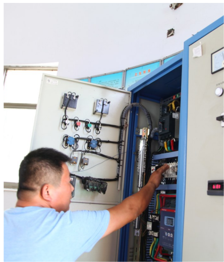
泵房设备维护
