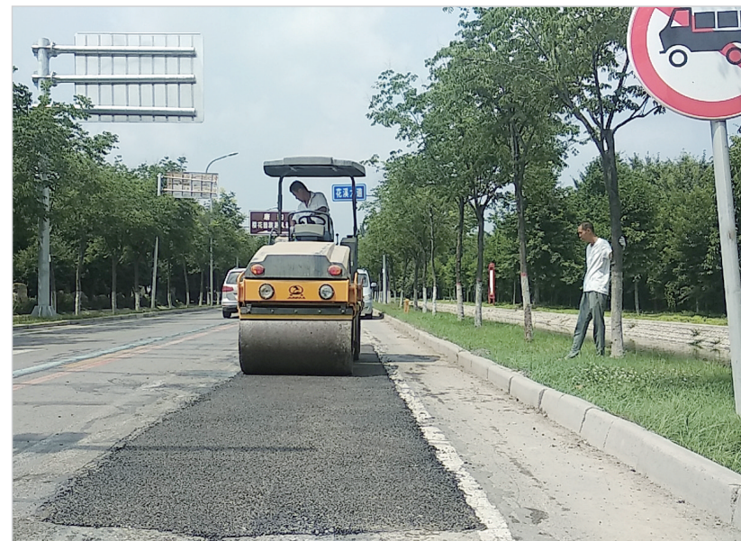
为进一步提高农村路面通行质量,确保来往车辆有序通行,连日来,鄢陵县农村公路管理所深入养护一线,排查摸底,对所管养公路路况进行了全面细致的检查和维修。图为鄢陵县农村公路管理所施工人员在乡村道路X007丁王线路段施工。 刘晓敏 摄
