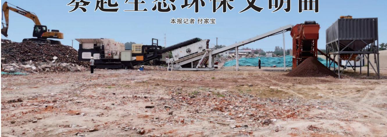
日前,在魏都区庞庄社区棚户区改造现场,施工过程中产生的建筑垃圾经过专业设备的破碎、筛分、分离等工序,直接变成了水泥稳定建筑垃圾再生集料,使得建筑垃圾“原地”开启了“再生之旅”。
