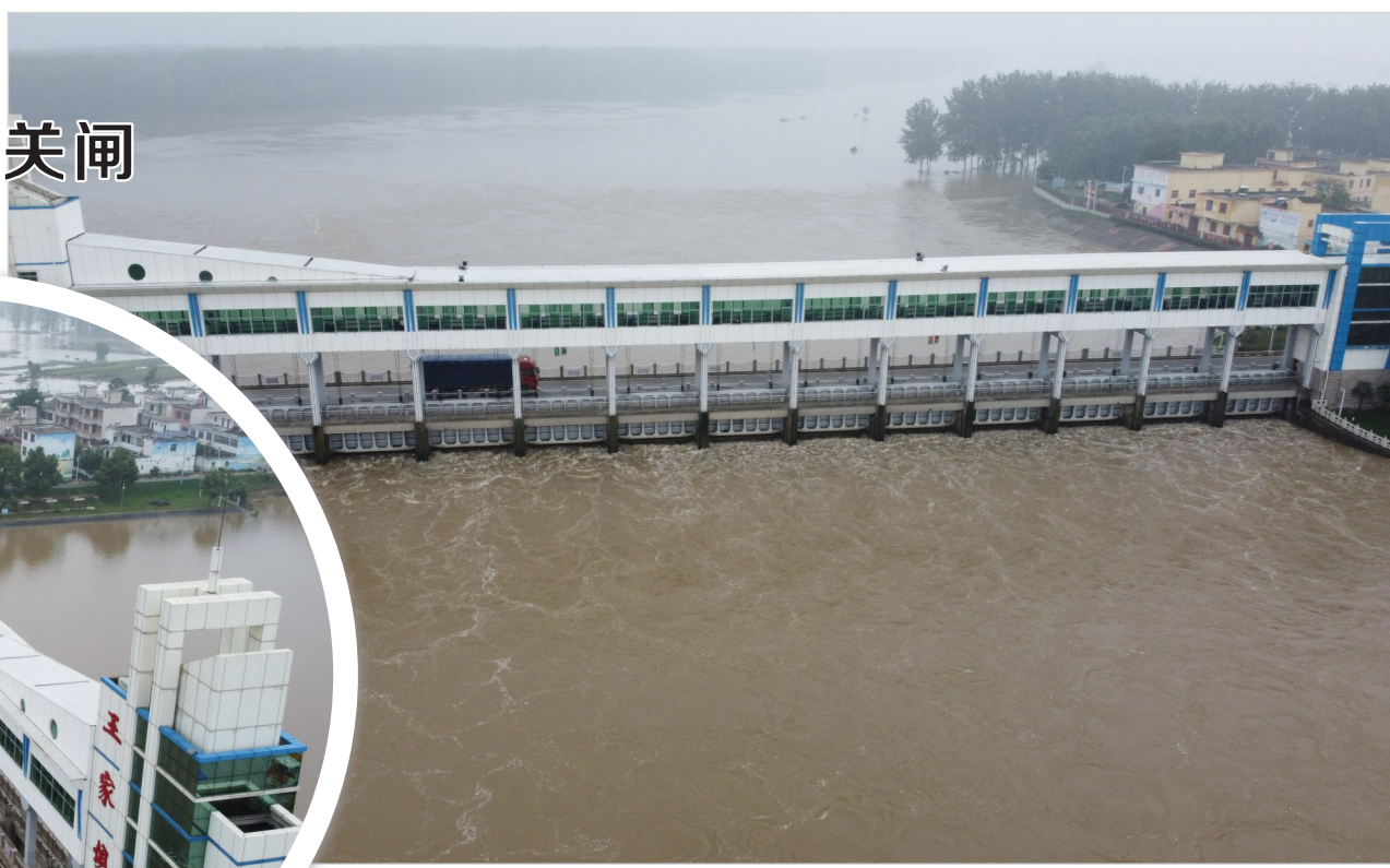
这是7月23日在安徽省阜南县拍摄的正在关闭的淮河王家坝闸(无人机照片)。当日13时,淮河干流王家坝闸关闸,停止向蒙洼蓄洪区泄洪。
