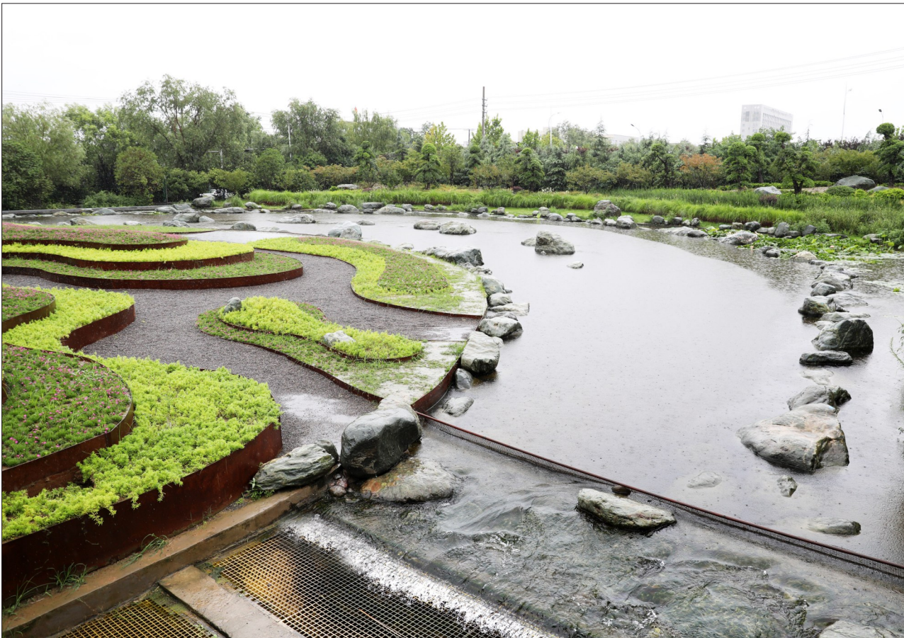
8月13日，记者在建安区清溪河堤岸的三达污水处理厂人工湿地看到，经过净化后的污水已成为河道景观用水。该人工湿地是我市水生态文明城市建设示范项目之一，利用砾石、植物、微生物的物理、化学、生物三重协同作用，改善、净化水质，每年可为清溪河补充大约1000万立方米的清洁中水，有效补充了清溪河的景观用水需求。
