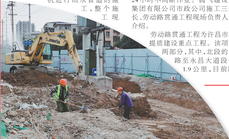
↑11月4日,劳动路贯通工程施工现场热火朝天。付家宝 摄
