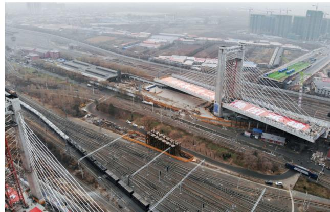
11月12日,由中铁二十二局集团一公司施工、总重达5.8万吨的哈尔滨市哈西大桥主塔和连续梁成功转体。在12米空中,这座国内跨越铁路既有线路最多的转体斜拉桥合龙。大桥上跨哈尔滨南站的48条铁路既有线路和1条市政主干道。
