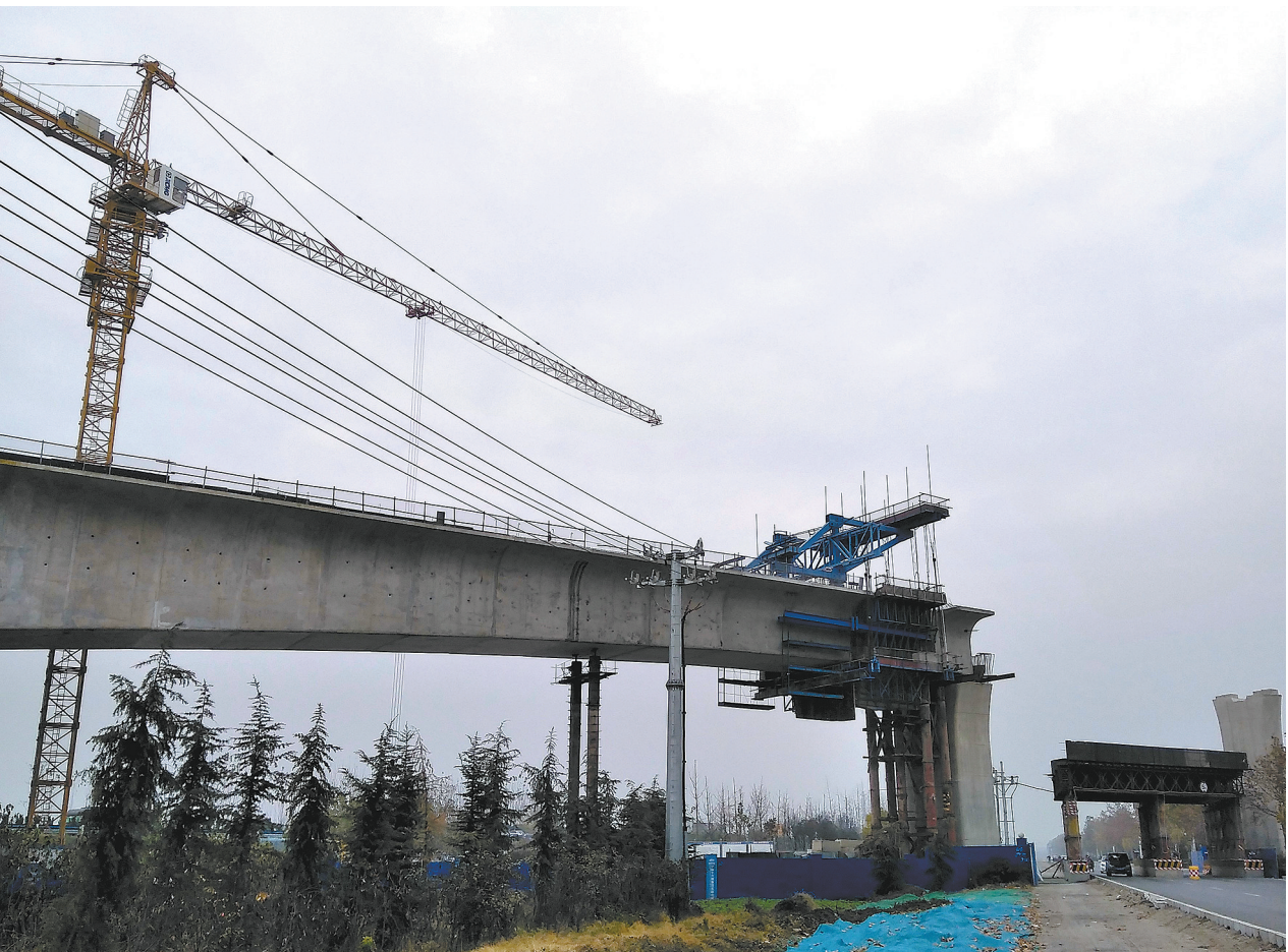
12月7日,施工人员在郑许市域铁路大周段紧张施工。郑许市域铁路是省、市重点项目,是郑许一体化的龙头工程,承建该项目的施工单位千方百计确保工程进展顺利。
