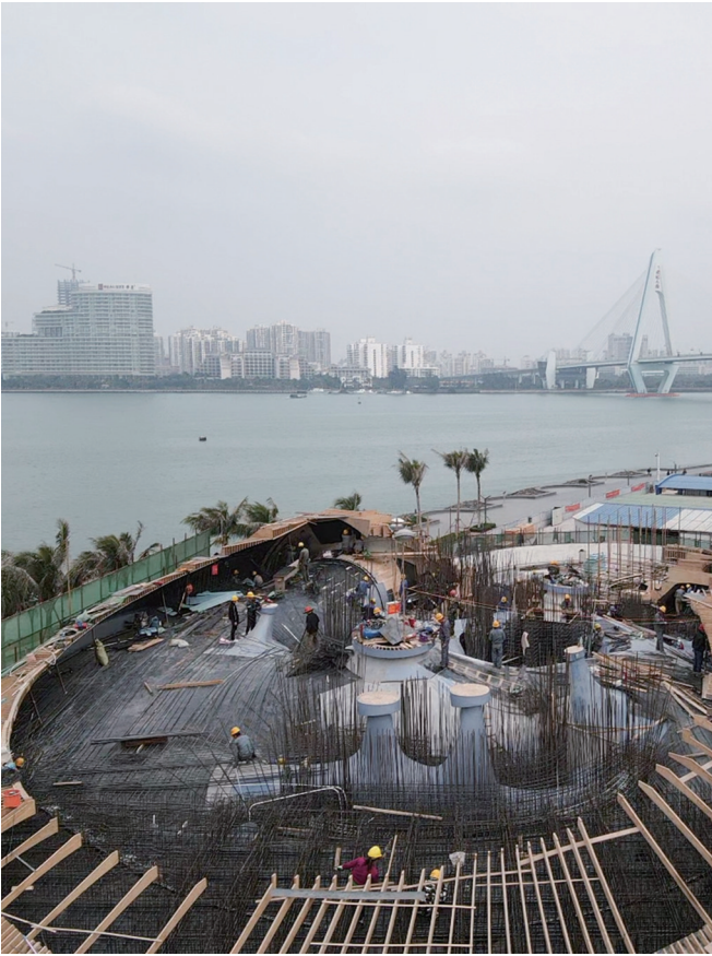
海口云洞图书馆项目加紧施工。1月6日拍摄的海口市云洞图书馆项目施工现场(无人机照片)。海口市云洞图书馆项目施工正在稳步推进,预计今年建成。云洞图书馆建成后将成为一个兼具图书馆和滨海步道驿站功能的公共空间,周边还可举行音乐会等户外演出活动。 新华社记者 张丽芸 摄
