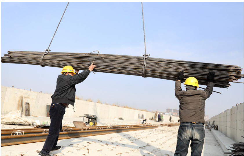
2月23日,郑许市域铁路长葛段北苑大道站,参建单位施工人員正在加紧项目建设。目前,长葛段北苑大道站站房钢构和二次结构施工正在有序开展,轨道放线测量和铺设工作稳步推进。本报记者 乔利峰 摄
