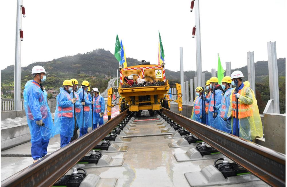
3月1日,在郑万高铁重庆段施工现场,施工人员进行铺轨前的准备工作。当日,随着第一组500米长钢轨输入无砟轨道,由中铁十一局负责的郑万高铁重庆段铺轨工程正式启动。郑万高铁是我国“八纵八横”高速铁路网中沿江通道和呼南通道的重要组成部分。该线路起于河南省郑州市,止于重庆市万州区,新建线路全长约818公里,设计时速350公里。新华社记者 唐奕 摄
