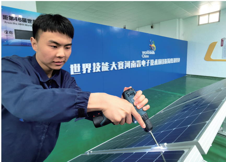
汪一帆在安装太阳能光伏板。
