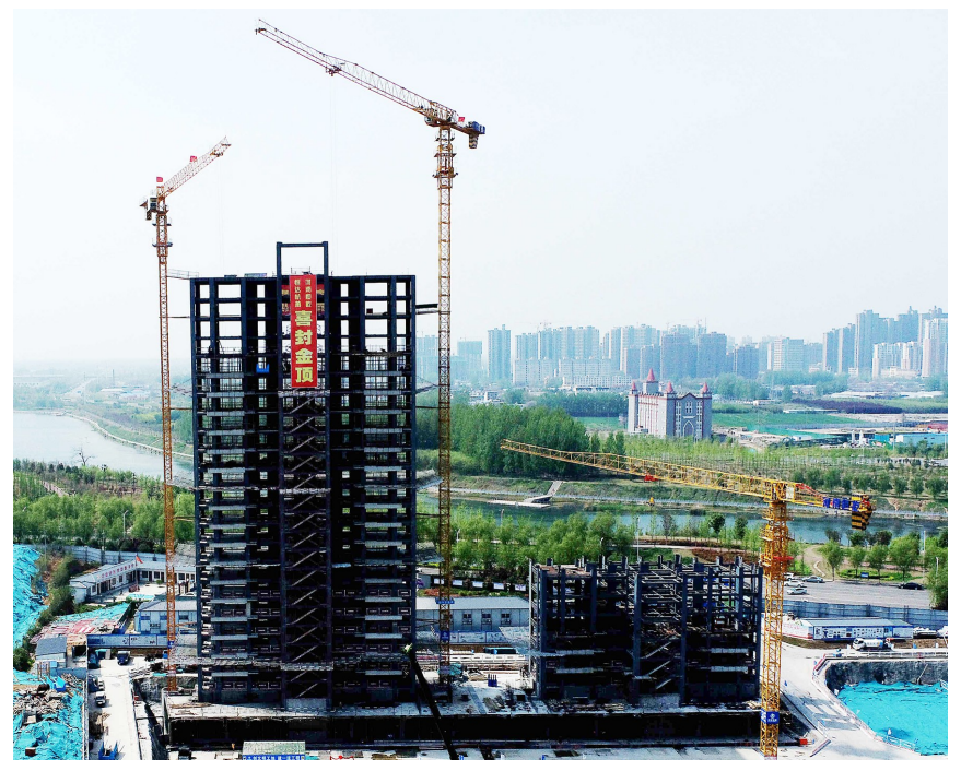
图为施工现场
