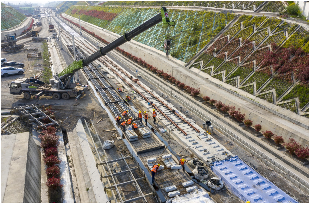
4月12日,在湖北省南漳县境内的郑万高铁南漳站,中铁十一局工人正在进行无砟轨道施工作业。目前,经过中铁十一局等参建单位建设者艰苦奋斗,郑万高铁湖北段进入无砟轨道施工冲刺。郑万高铁全长818公里,设计时速350公里,起于郑州南站,经过湖北、重庆,终到万州北站,是我国“八纵八横”高铁网中京昆通道的重要组成部分。新华社记者 杜华举 摄
