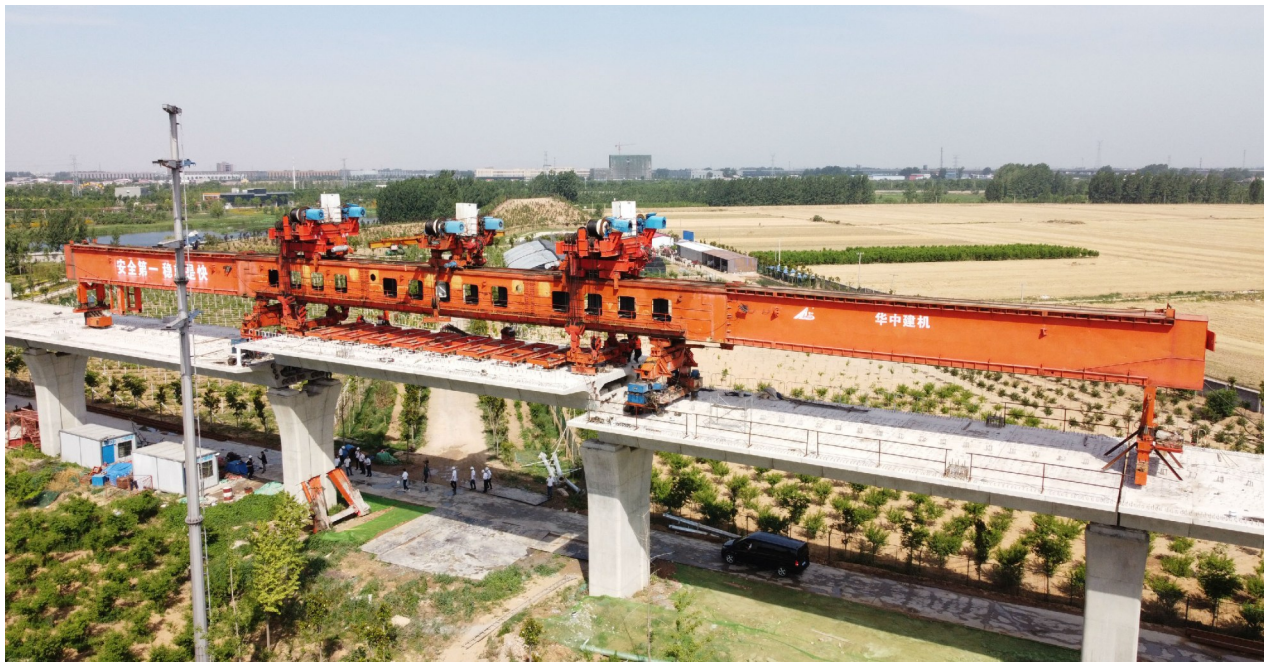
图为最后一孔节段梁在架桥机的吊装下精确落位。
