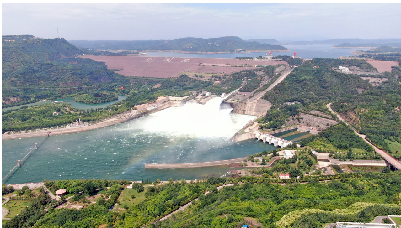
这是6月19日拍摄的黄河小浪底水利枢纽工程（无人机照片）。
