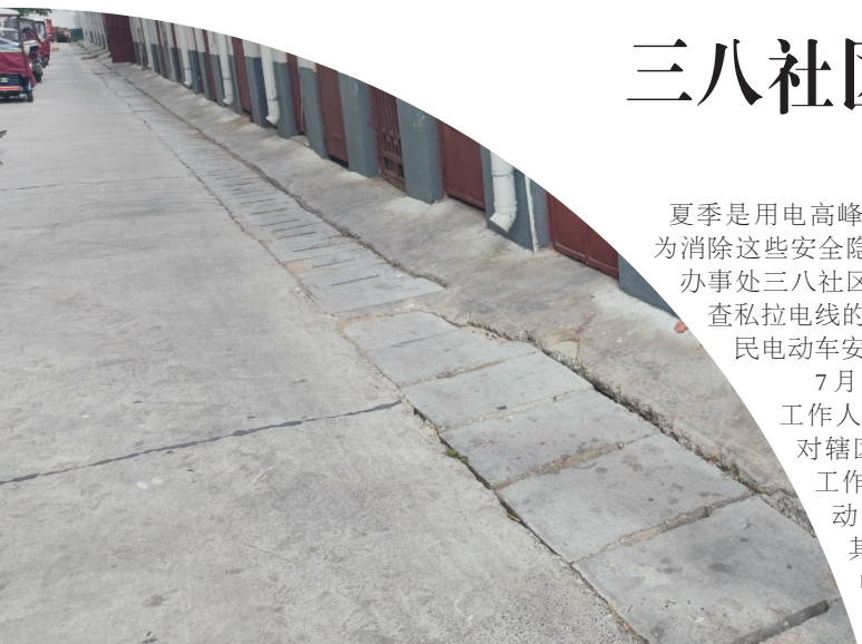
▲污水管道改造后,楼院内环境干净又整洁
