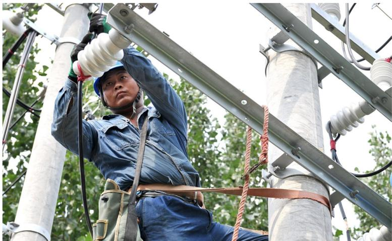
连日来,持续的高温让我市进入“烧烤模式”,为了让居民“清凉”度夏,许昌供电公司的电力抢修人员战骄阳、冒酷暑,在炎炎烈日下忙碌着。图为7月14日,许昌供电公司配电抢修人员对八一路洞上村配变下户线烧断故障进行处理。 焦永生 摄
