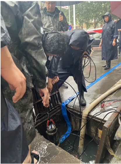
怡兴物业应急抢险队冒雨疏通管道。 毛宝君 摄
