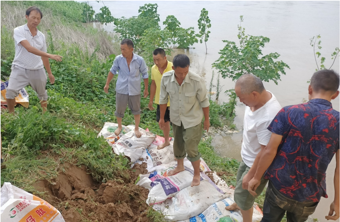
从7月20日下午开始,在双洎河鄢陵县孙村段,驻村第一书记、党员干部、当地群众一直在加固堤坝。张莹 摄
