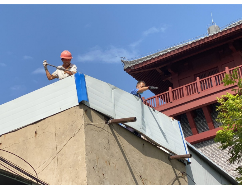
8月26日,在魏都区东大街街道办事处平安社区,工作人员正对违章建筑实施拆除。据了解,自房屋安全隐患集中整治活动开展以来,东大街街道办事处已累计拆除违章建筑29220平方米,完成总任务的93%。 许廷合 摄
