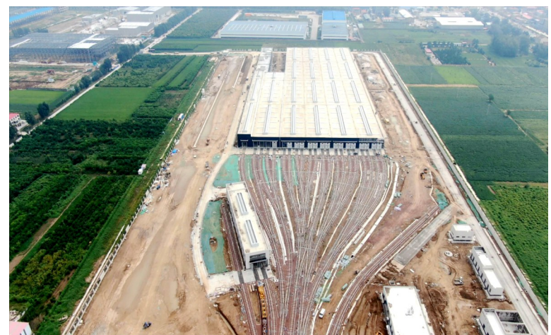
梅庄停车场是郑许市域铁路许昌段唯一的停车场,目前已完成95%。
