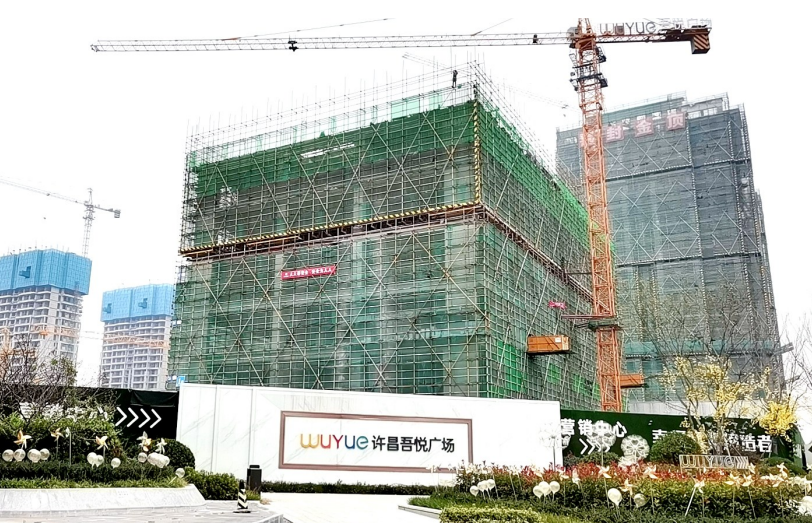
正在建设中的许昌吾悦广场。
