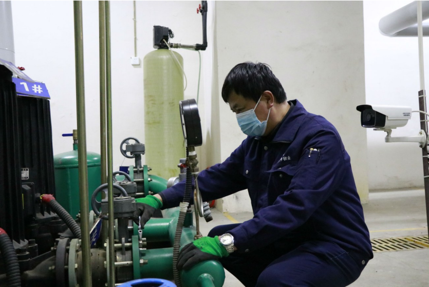
瑞贝卡物业工程人员在检查供暖设施。
