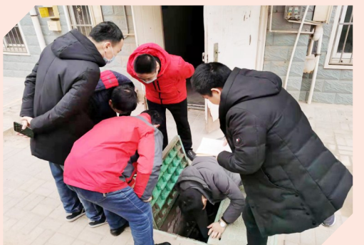
供热工作人员正在维修小区供热设施 (均为资料图片)
