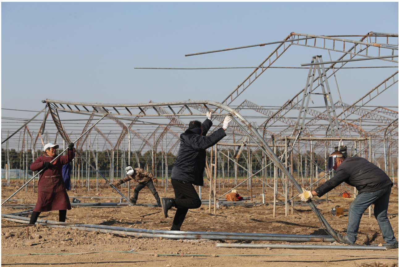
12月27日,村民在鄢陵县森鹏绿色农业有限公司搭建果蔬大棚。寒冬时节,在位于鄢陵县马坊镇孙村的鄢陵县森鹏绿色农业有限公司,村民们趁着农闲时节打桩、立架、焊接,加紧搭建果蔬大棚,为来年的春耕、丰产和增收做准备。
