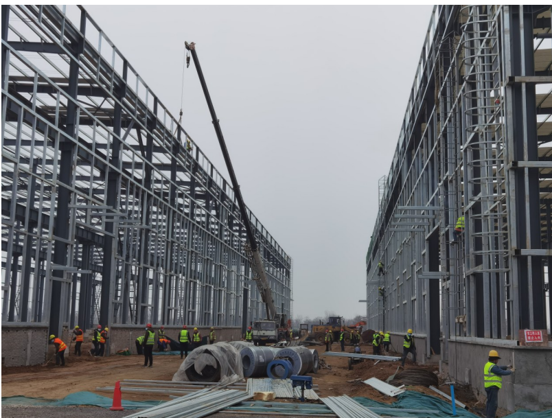
图为河南纵横精工轨道交通装备生产项目施工现场。该项目计划年底前建成投产。
