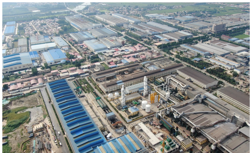
大周循环经济产业园一角鸟瞰
