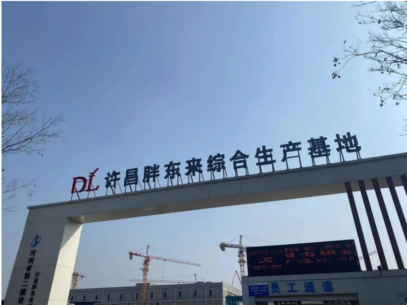
图为胖东来综合生产基地项目建设现场 王金伟摄
