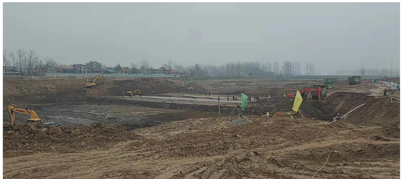
影店同修施工现场。资料图片
