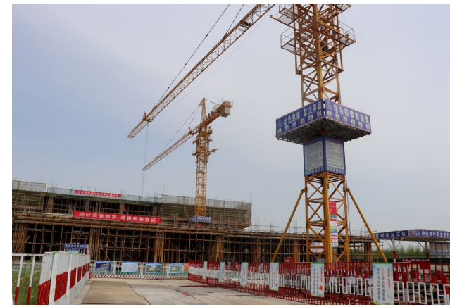
东城区人民医院项目建设现场
