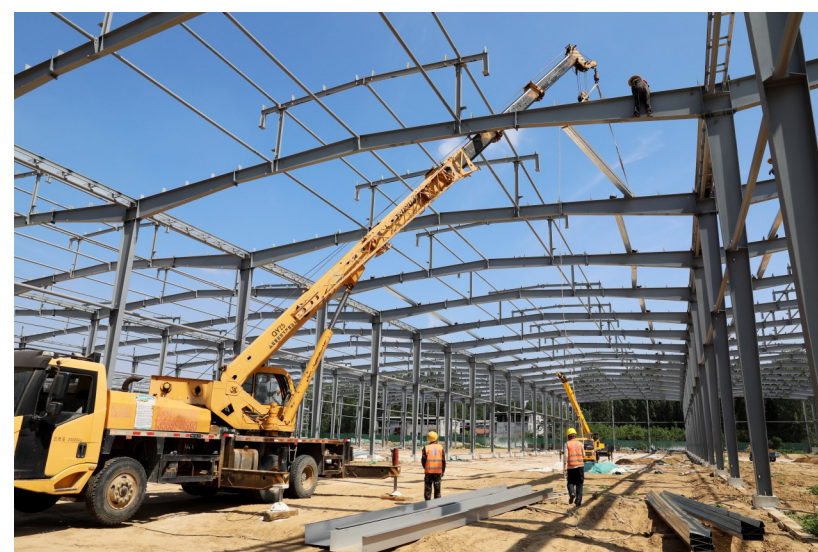
6月22日,在位于建安区的远东传动轴智能产业园三期项目工地上,工人们在高温下采取错峰施工措施,加紧车间厂房钢结构建设。该项目建成后,主要进行传动轴锻造件、热处理的生产,具备年产10万吨非等速传动轴锻件的产能。本报记者 乔利峰 摄
