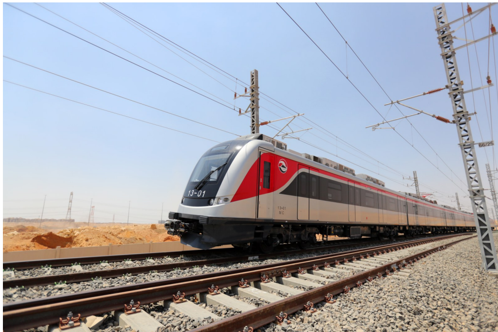
这是7月3日在埃及开罗东部拍摄的一列驶向埃及新行政首都方向的试运行轻轨列车。由中国企业承建的埃及斋月十日城轻轨铁路3日通车试运行,这是埃及第一条电气化铁路。埃及斋月十日城轻轨铁路位于埃及首都开罗东部,是连接开罗市区与新行政首都、斋月十日城和东部沿线卫星城的重要纽带,也是中埃“一带一路”合作旗舰项目之一。
