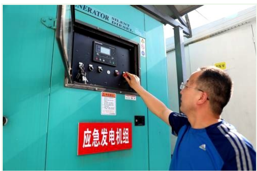
检修应急设备。
