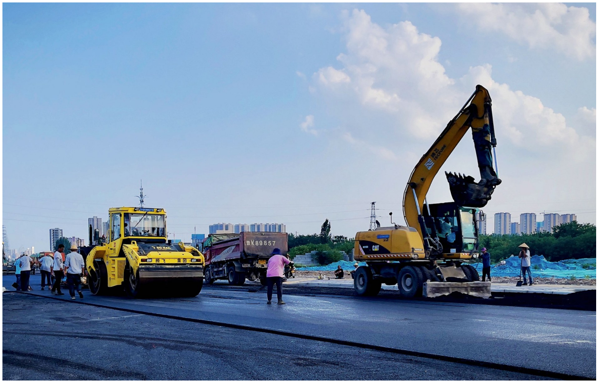
7月9日,市区劳动路北段路面拓宽工程现场,施工人员抢抓工期,不畏酷暑,在高温下铺设沥青。
