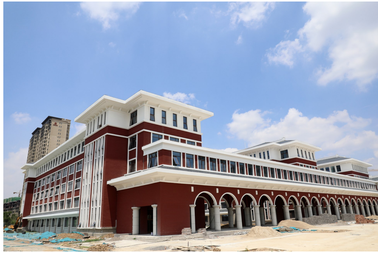
图为7月7日记者拍摄的建安区第一高级中学新校区教学楼。该项目计划总投资8.77亿元,建筑面积23.6万平方米,规划建设120个寄宿制高中班,投入使用新增高中学位6000个。 本报记者 乔利峰 摄
