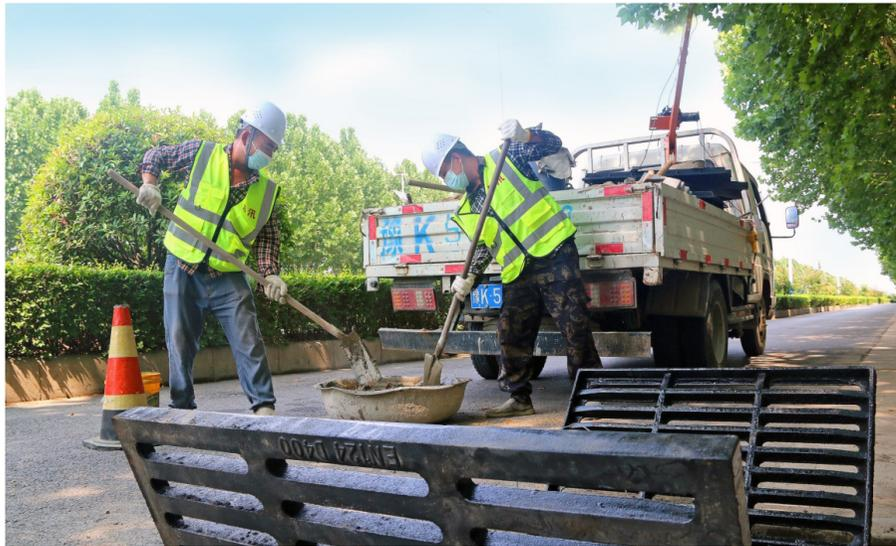
8月2日,建安新区元大道,市政工人正在更换窨井盖。据悉,我市自公共区域窨井盖专项整治工作开展以来,累计整治提升窨井设施49959个,更换窨井盖26772个,安装防坠网33722套,从源头上消除安全隐患,守护市民的“脚下安全”。
