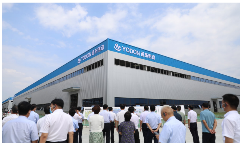
远东汽车传动系智能制造产业园项目 本报记者 乔利峰 摄
