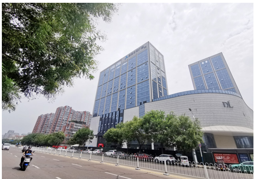
8月18日,位于市区八龙路南段的建安文化广场项目主体完工。该项目总建筑面积15万平方米,是集文化、体育、休闲广场于一体的商业综合体,全面建成后将进一步提升许昌的城市形象,拉动周边区域经济发展。本报记者 乔利峰 摄
